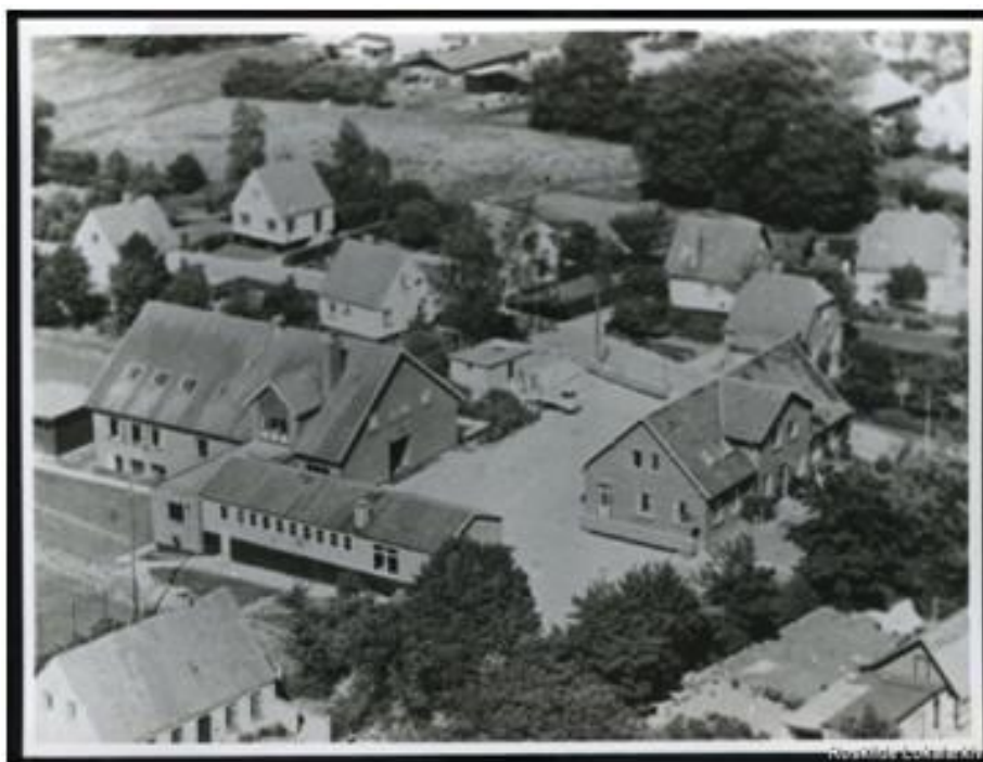
Svogerslev Skole, nu kaldet Sct. Andreasskolen, bygget år 1900.
